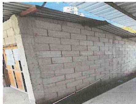
Foto 2: Repeyo de muros interiores y exteriores en la cocina.
