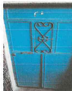
Foto 6: Mantenimiento a puertas de metal.
