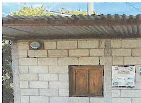
Foto 3: sustitucion de ventana de madera por PVC.
