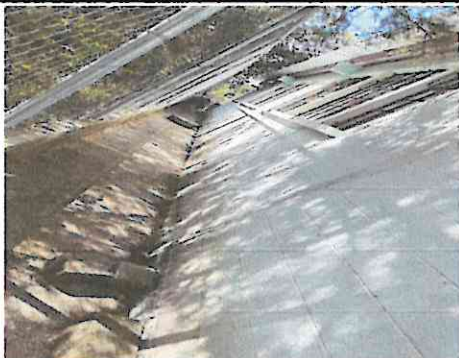
Foto1: Sustitución de pintura por deterioro en interiores y exteriores.
